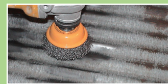
SCHRITT 1: ENTFERNEN SIE LOSEN ROST
