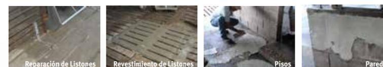
Con-Korite Xtra es mezclado con agua y para la resistencia añadida a la absorción de líquidos y la mejora de unión de la Resina Acrílica KB25 se combina con agua antes de mezclar el mortero. **Cada Funda 55 Libras requiere entre 1 – 1.25 Galones de líquidos de mezclado.**
